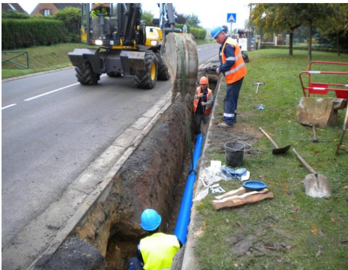
Des canalisations souterraines
