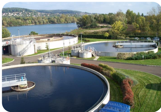
Une station d'épuration
